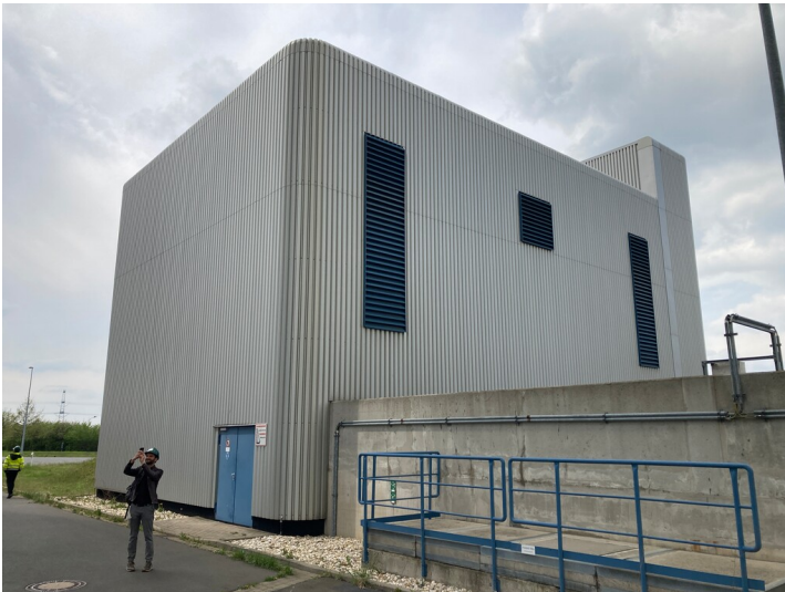
Kraftwerk Lippendorf, Kühlwasserpumpenhaus R, Blick von Osten Fotograf/Urheber: Nils Schinker
