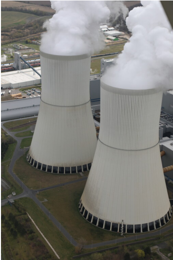
Kraftwerk Lippendorf, Naturzug-Nasskühlturm R und S, Schrägluftaufnahme Fotograf/Urheber: Ronald Heynowski
