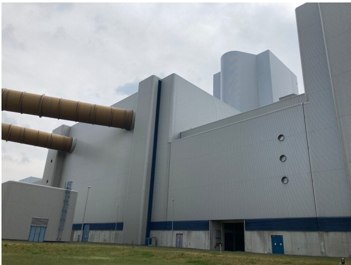
Kraftwerk Lippendorf, Rauchgasentschwefelungsanlage, Blick von Nordwest auf mittigen Gebäudeteil mit Schaltanlagen Fotograf/Urheber: Nils Schinker
