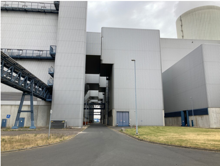
Kraftwerk Lippendorf, Saugzuggebäude, Blick von Osten Fotograf/Urheber: Josephine Dressler
