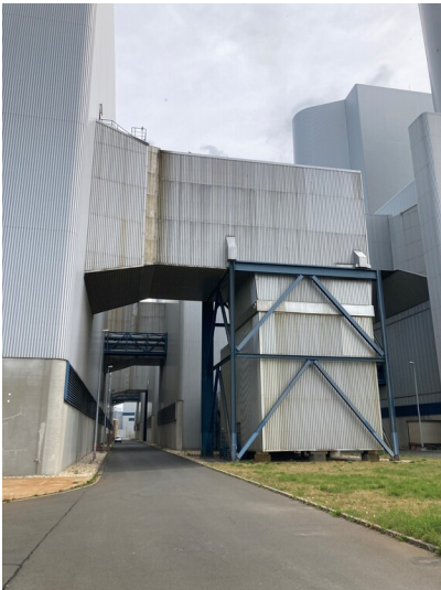
Kraftwerk Lippendorf, Saugzuggebäude, Blick von Westen Fotograf/Urheber: Nils Schinker
