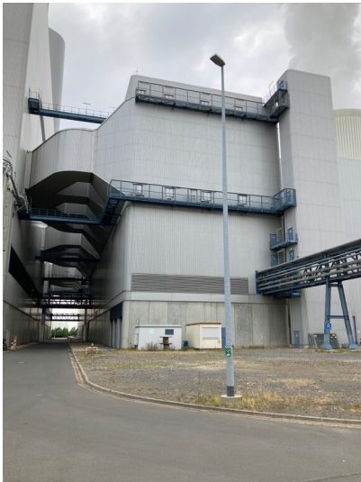
Kraftwerk Lippendorf, Gebäude der Elektro-Filteranlage S mit Aschebandförderbrücke, Blick nach Westen Fotograf/Urheber: Josephine Dressler
