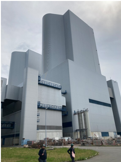
Kraftwerk Lippendorf, Gebäude der Elektro-Filteranlage R, Blick von Südwest Fotograf/Urheber: Nils Schinker
