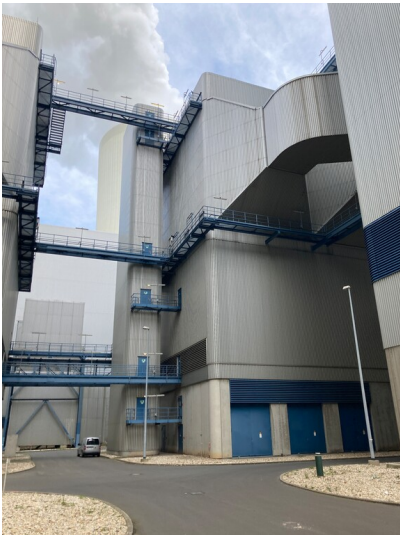
Kraftwerk Lippendorf, Dampfüberleiter S, Blick nach Norden Fotograf/Urheber: Nils Schinker
