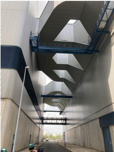
Kraftwerk Lippendorf, Dampfüberleiter R, Blick nach Westen Fotograf/Urheber: Nils Schinker
