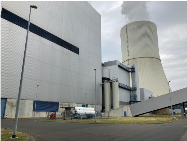
Kraftwerk Lippendorf, östliches Kesselhaus (Dampferzeuger S), Blick von Südost Fotograf/Urheber: Josephine Dressler
