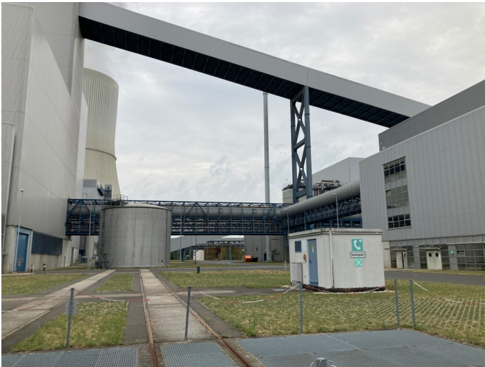
Kraftwerk Lippendorf, Kalkkondensatspeicher S, Blick von Süden Fotograf/Urheber: Josephine Dressler
