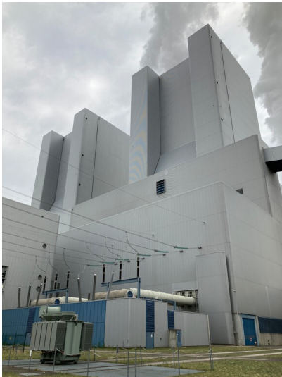
Kraftwerk Lippendorf, östlicher Teil (Block S) des Maschinenhauses, Blick von Südost Fotograf/Urheber: Josephine Dressler
