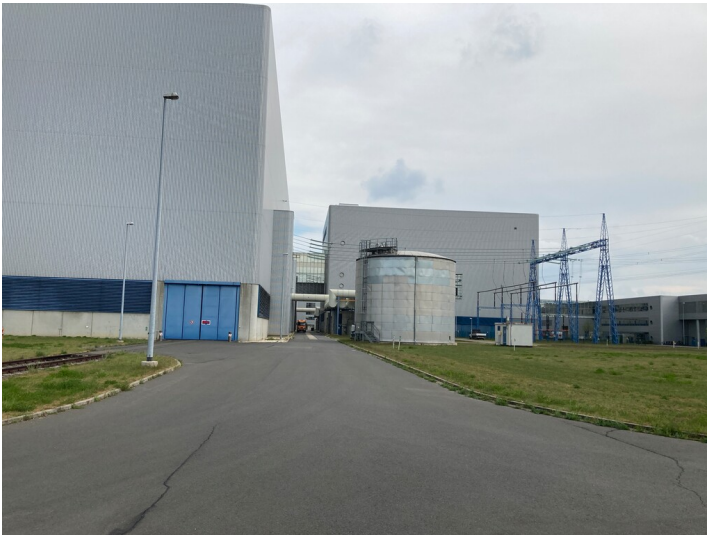
Kraftwerk Lippendorf, Kalkkondensatspeicher R, Ansicht von Osten Fotograf/Urheber: Nils Schinker
