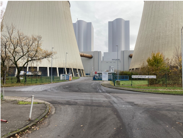
Kraftwerk Lippendorf, Pförtnergebäude Güterverkehr, Nordansicht Fotograf/Urheber: Nils Schinker
