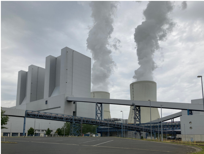
Kraftwerk Lippendorf, Kohlebandförderbrücke, Blick von Südost Fotograf/Urheber: Josephine Dressler
