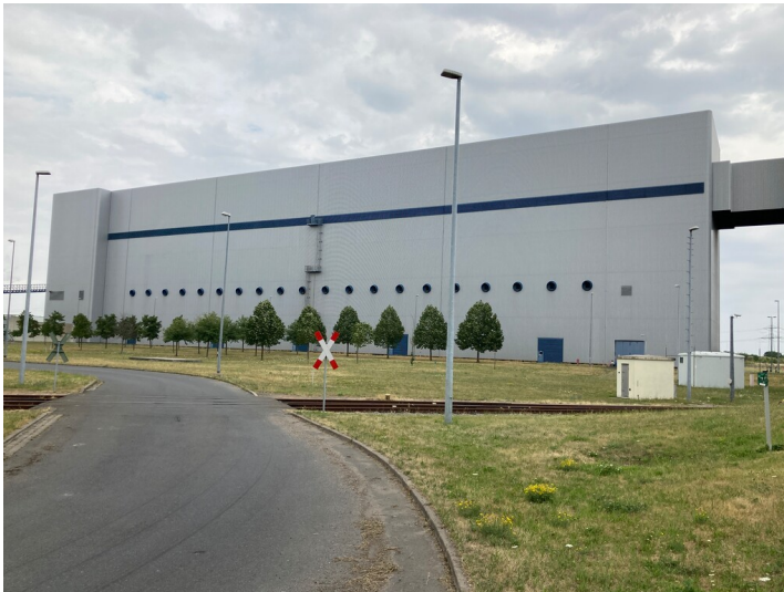
Kraftwerk Lippendorf, Kohlezwischenbunker, Ansicht von Südwest Fotograf/Urheber: Josephine Dressler
