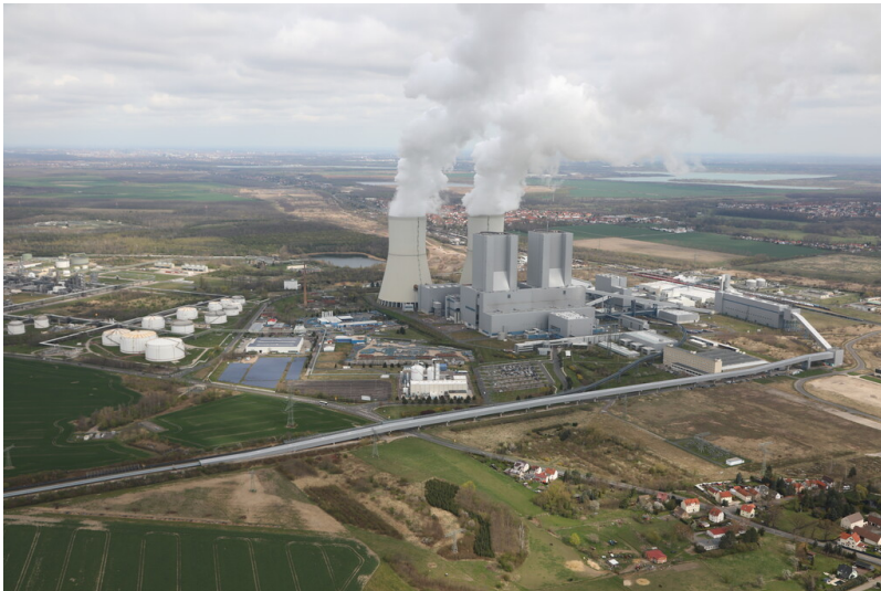
Kraftwerk Lippendorf, Schrägluftbild von Südwest Fotograf/Urheber: Ronald Heynowski
