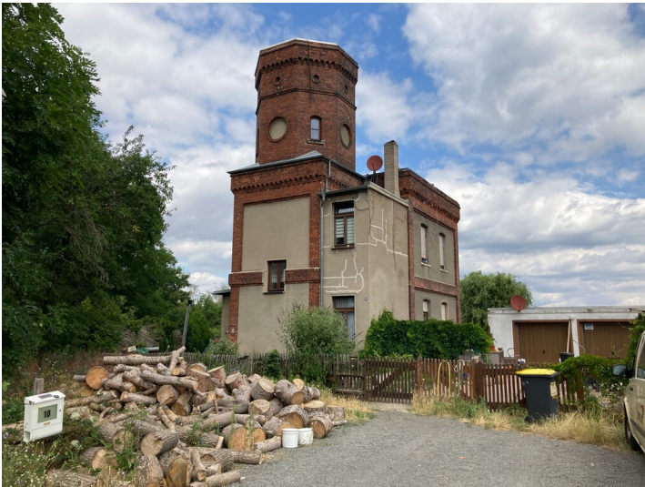
Verwaltungsgebäude des ehemaligen Braunkohlewerkes Zwenkau, Blick nach Norden Fotograf/Urheber: Josephine Dressler
