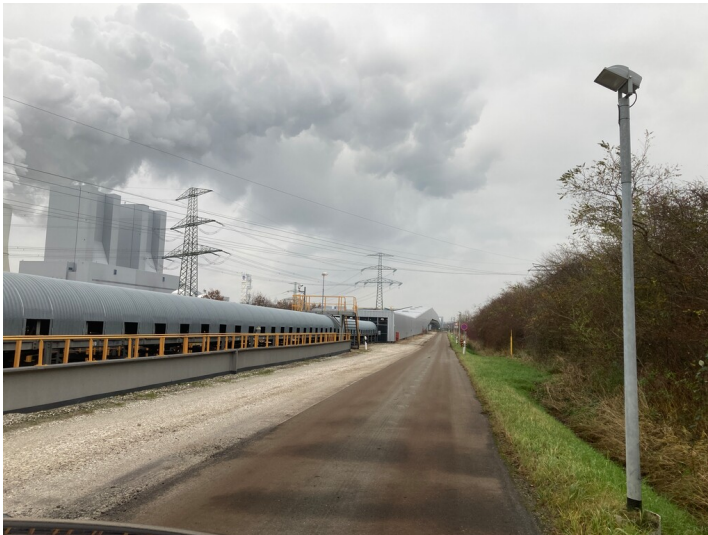
Tagebau Vereinigtes Schleenhain, Bandförderanlage vom Kohlemisch- und Stapelplatz zum Kohlezwischenbunker im Kraftwerk Lippendorf, Blick nach Norden Fotograf/Urheber: Nils Schinker
