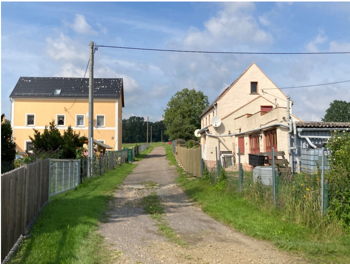
Steigerhaus Braunkohlenwerk Julius & Hahn, Blick nach Nordwesten Fotograf/Urheber: Josephine Dressler
