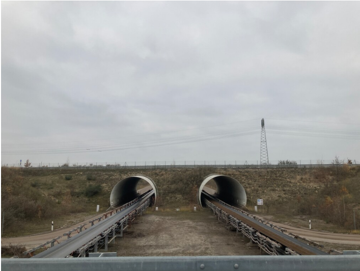
Tagebau Vereinigtes Schleenhain, Tunnelröhren für Bandanlagen und Erschließungsstraße Fotograf/Urheber: Nils Schinker
