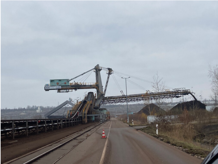
Tagebau Vereinigtes Schleenhain, Bandschleifenwagen mit Abwurftrömmel und Schienenfahrwerk Fotograf/Urheber: Nils Schinker
