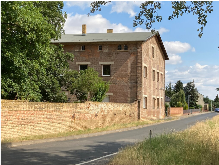
Zweigeschossiges Magazingebäude mit Drempel, Blick nach Nordwest Fotograf/Urheber: Josephine Dressler
