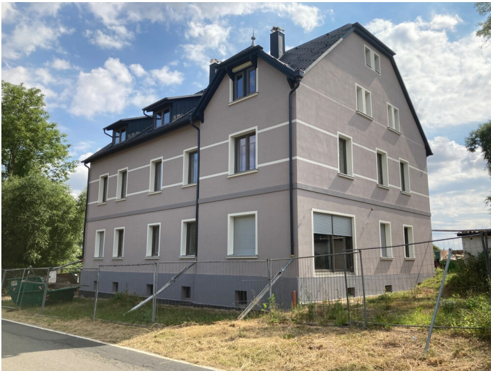
Steigerhaus Grube Bertha, Schrägansicht von Südwest Fotograf/Urheber: Josephine Dressler
