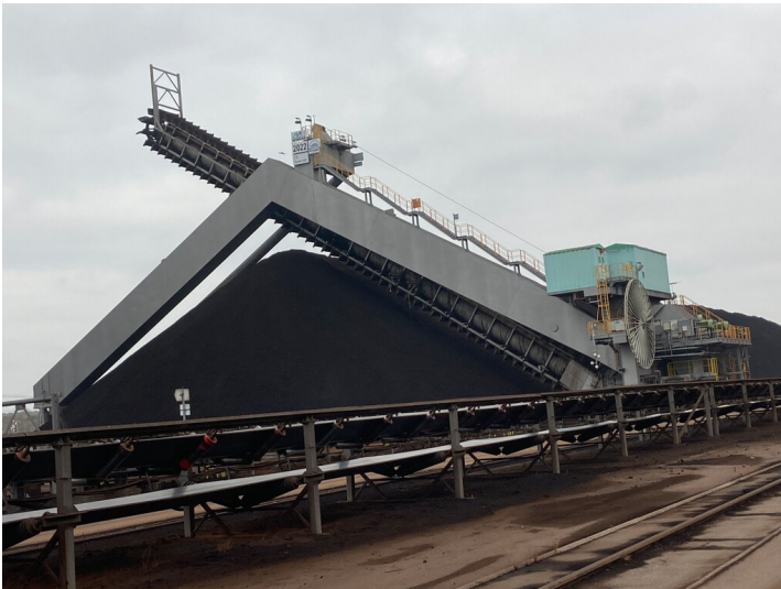
Tagebau Vereinigtes Schleenhain, Portalkratzer am Kohlemisch-und-Stapelplatz, Blick nach Norden Fotograf/Urheber: Nils Schinker
