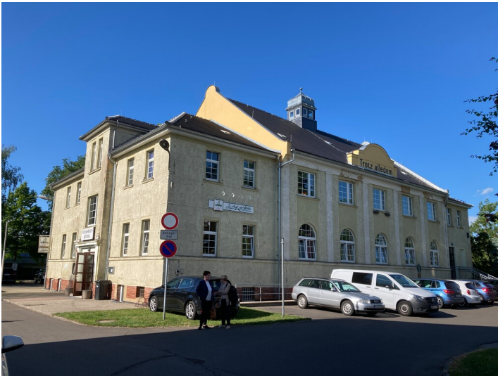
Gewerkschaftshaus, Blick nach Nordost Fotograf/Urheber: Nils Schinker
