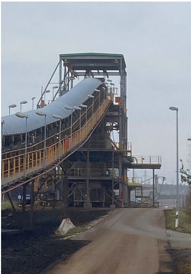
Tagebau Vereinigtes Schleenhain, Brecherturm mit Hammerprobennehmer, Blick nach Norden Fotograf/Urheber: Nils Schinker
