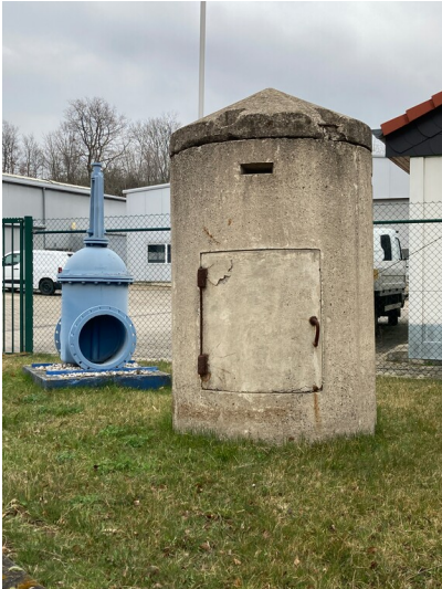
Splitterschutzzelle aus Beton, Ansicht von Westen Fotograf/Urheber: Nils Schinker
