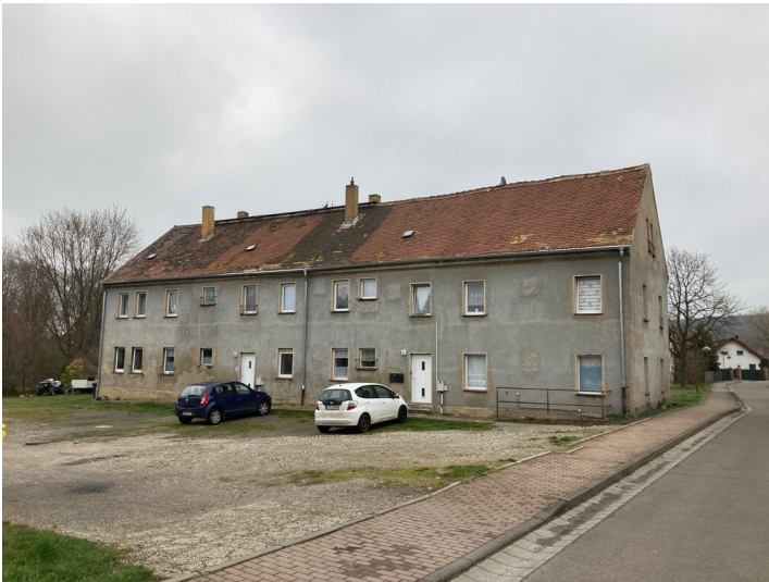
Gut Krobitzsch, Einbau von Werkwohnungen in ehemaliges Stall- und Scheunengebäude, Blick nach Nordost Fotograf/Urheber: Nils Schinker
