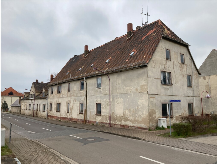
Gut Heinrich, Wohnhaus an der Mölbiser Hauptstraße, Blick nach Nordost Fotograf/Urheber: Nils Schinker
