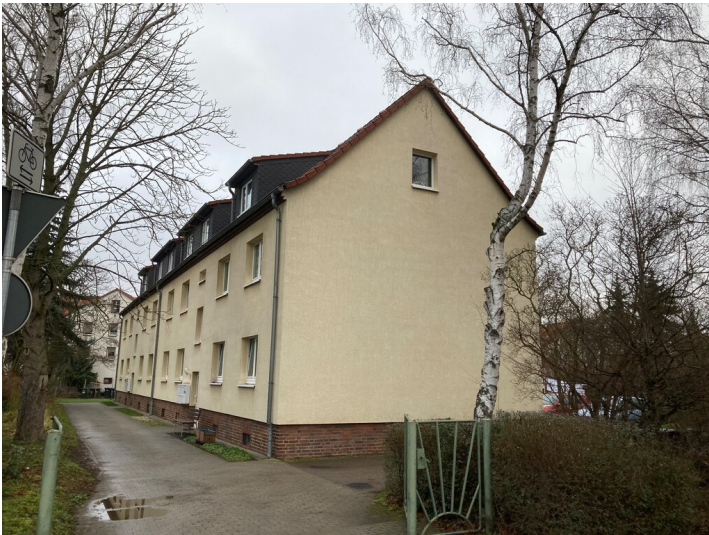
Wohnblock an der Leipziger Straße, Blick nach Nordost Fotograf/Urheber: Nils Schinker
