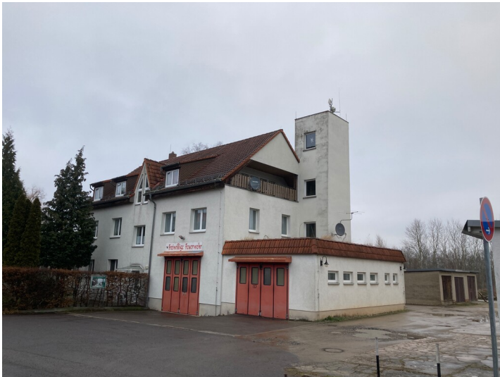
Feuerwehrgerätehaus mit Wohnungen und Steigturm der Freiwilligen Feuerwehr Espenhain, Blick von Südost Fotograf/Urheber: Nils Schinker
