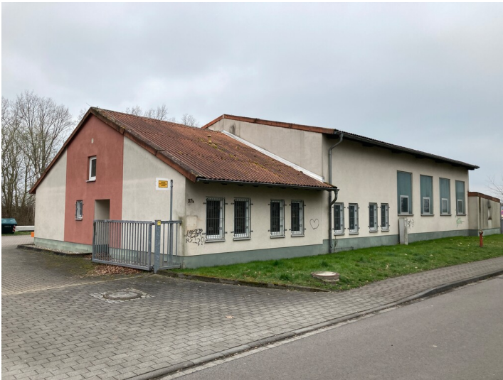
Ehemaliges Heizhaus der Otto-Heinig-Siedlung, heute kommunaler Bauhof, Blick nach Westen Fotograf/Urheber: Nils Schinker
