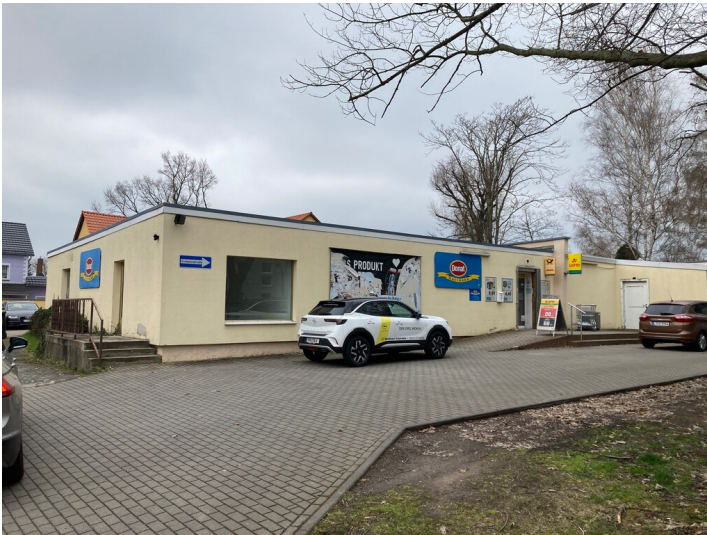
Kaufhalle in der Siedlung Otto-Heinig-Straße, Blick nach Nordost Fotograf/Urheber: Nils Schinker
