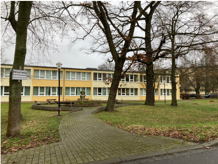
Gebäude der ehemaligen Kinderkrippe, heute Sitz der Gemeindeverwaltung, Blick nach Nordost Fotograf/Urheber: Nils Schinker
