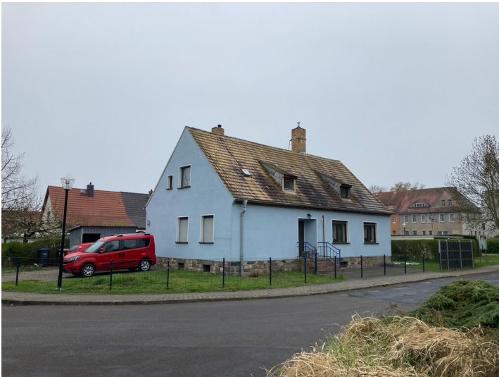
ehemalige Gemeindebibliothek, heute Wohnhaus, Blick von Norden Fotograf/Urheber: Nils Schinker
