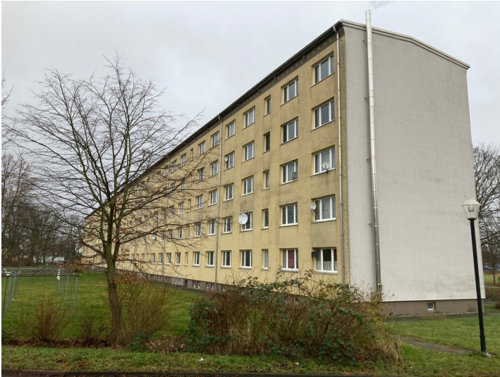
Wohnkomplex der Typen-Reihe Brandenburg in der Siedlung Otto-Heinig-Straße Fotograf/Urheber: Nils Schinker
