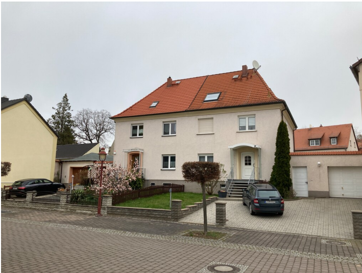
Betriebsleitervilla in der Bauernstraße, Blick von Südwest Fotograf/Urheber: Nils Schinker
