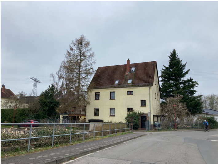
Umsiedlerhaus an der Hugo-Joachim-Straße, Blick von Nordost Fotograf/Urheber: Nils Schinker
