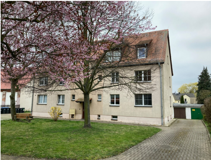
Mehrfamilienhaus und ehemaliger Polizeiposten der Gemeinde Espenhain, Ostansicht Fotograf/Urheber: Nils Schinker
