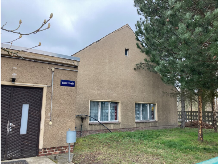
Kegelsporthalle, Eingangsseite, Blick von Südost Fotograf/Urheber: Ullrich Ochs
