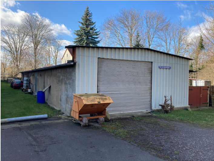
Baracke ehemaliges Wohnlager I, Blick nach Nordwest Fotograf/Urheber: Ullrich Ochs
