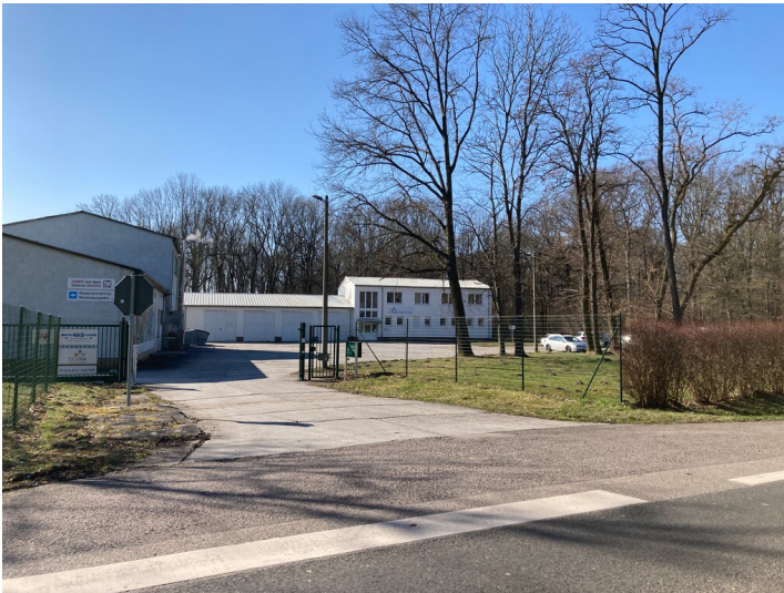
Kraftwerk Thierbach, Sozial- und Werkstattgebäude sowie Lagerhallen, Blick von Nordost Fotograf/Urheber: Nils Schinker
