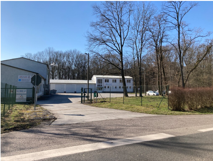
Kraftwerk Thierbach, Sozial- und Werkstattgebäude sowie Lagerhallen, Blick von Nordost Fotograf/Urheber: Nils Schinker
