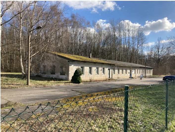
Kraftwerk Thierbach, zwei Baracken in Blockbauweise, Blick von Nordwest Fotograf/Urheber: Nils Schinker
