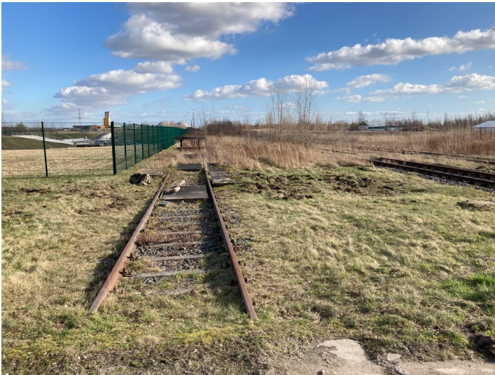
Kraftwerk Thierbach, Gleisanlagen, Blick nach Südost Fotograf/Urheber: Nils Schinker
