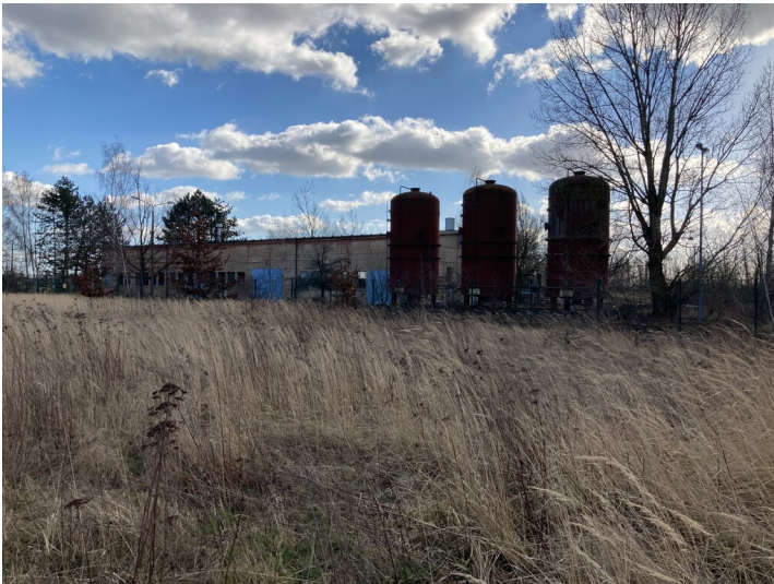
Kraftwerk Thierbach, Pumpenhaus, drei Tanks und Auffangbecken, Blick von Norden Fotograf/Urheber: Josephine Dressler
