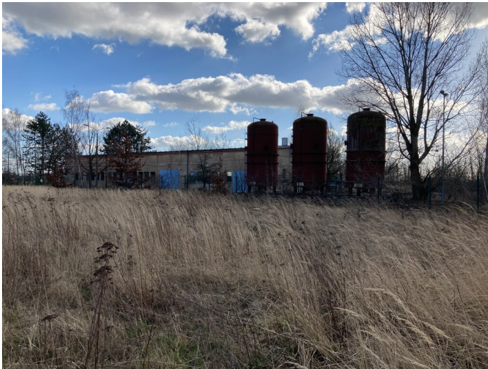
Kraftwerk Thierbach, Pumpenhaus, drei Tanks und Auffangbecken, Blick von Norden Fotograf/Urheber: Josephine Dressler
