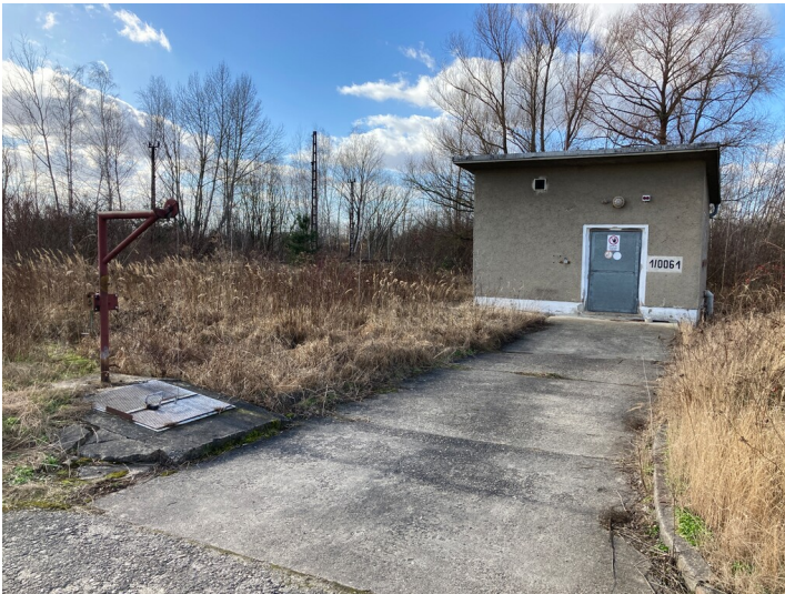
Kraftwerk Thierbach, Pumpenhaus zur Abwasserregulierung, Blick von Südost Fotograf/Urheber: Nils Schinker
