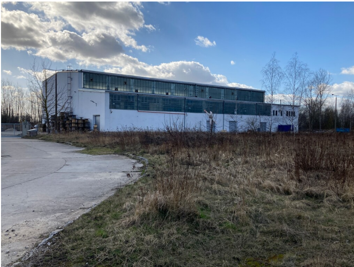
Kraftwerk Thierbach, Halle der Wasseraufbereitung, Blick von Nordost Fotograf/Urheber: Josephine Dressler
