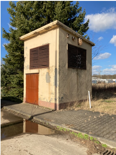
Kraftwerk Thierbach, Schachtgebäude zur Brauchwasserregulierung, Blick von Südost Fotograf/Urheber: Nils Schinker
