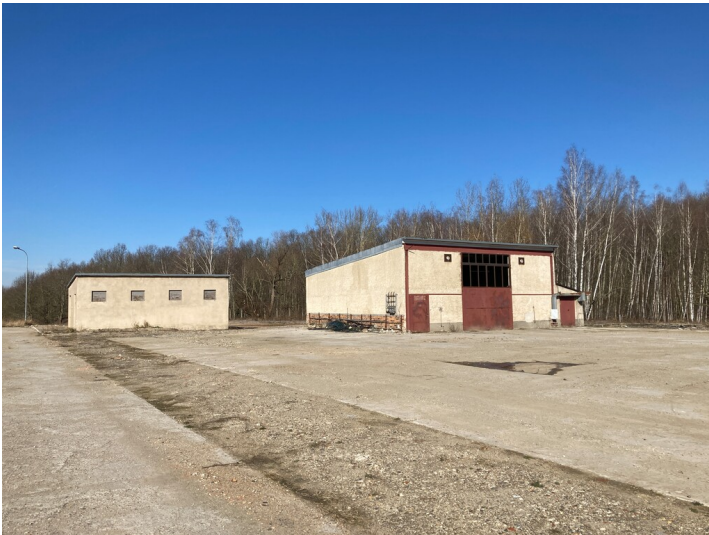
Kraftwerk Thierbach, Garage und Transformatorstation, Blick von Süden Fotograf/Urheber: Nils Schinker
